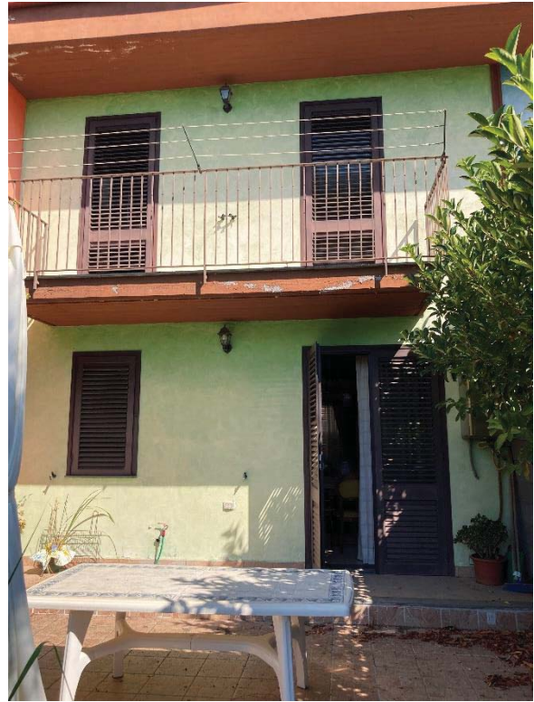
Piano terra (sub 43) corte pertinenziale
